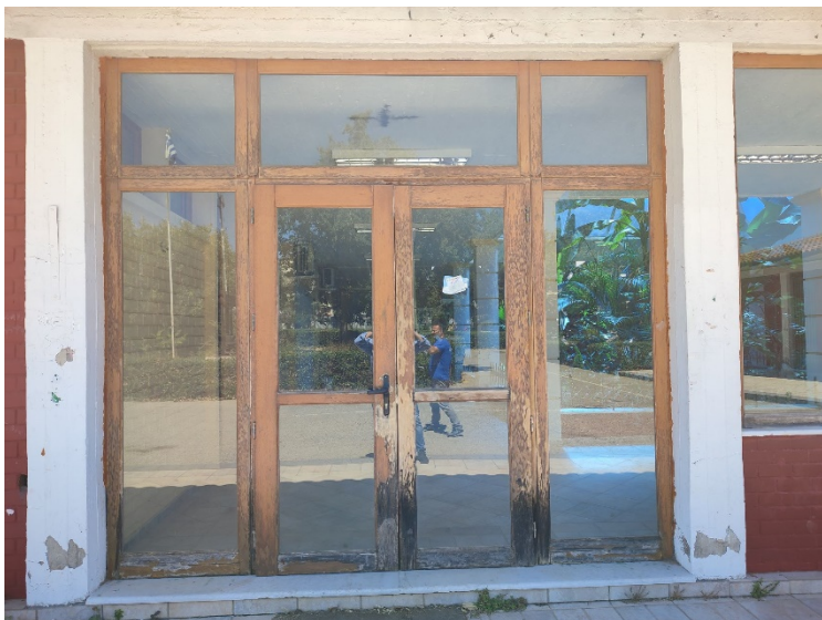
ΥΦΙΣΤΑΜΕΝΕΣ ΞΥΛΙΝΕΣ ΘΥΡΕΣ
