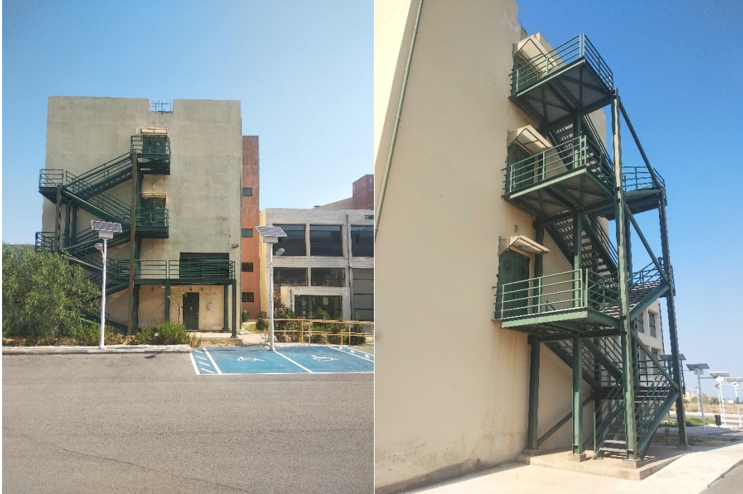
Φωτογραφία 1: Θύρες στα μεταλλικά κλιμακοστάσια προς αντικατάσταση.
