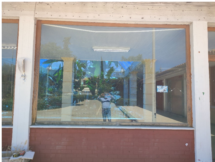
ΥΦΙΣΤΑΜΕΝΑ ΞΥΛΙΝΑ ΥΑΛΟΣΤΑΣΙΑ
