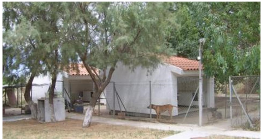
Κάποιες από τις εγκαταστάσεις του Σταθμού Μέριμνας Ζώων του Πανεπιστημίου Πατρών
